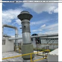
Fotografía No. 20 Ducto, plataforma y puertos de muestreo del Filtro Ocrim
