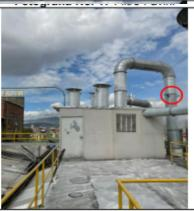
Fotografía No. 19 Ducto, plataforma y puertos de muestreo del Filtro Favini (caja de almacenamiento)
