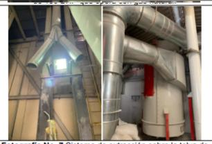
Fotografía No. 7 Sistema de extracción sobre la tolva de descarga y filtro de mangas al cual conduce.
